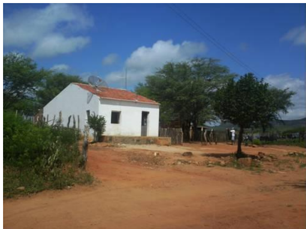
Figura 7. Casa de alvenaria.
