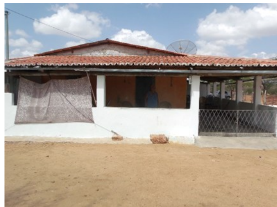
Foto 15 - Casa de alvenaria
